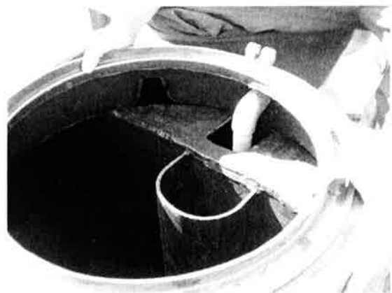
写真-3 処理量5m 3 /日で嫌気沈殿ゾーン (HRT22hr)+好気ゾーン(16hr)からなる modified septic tank。 右側は好気ゾーンで, 手前側が嫌気の沈殿ゾ ーン。
