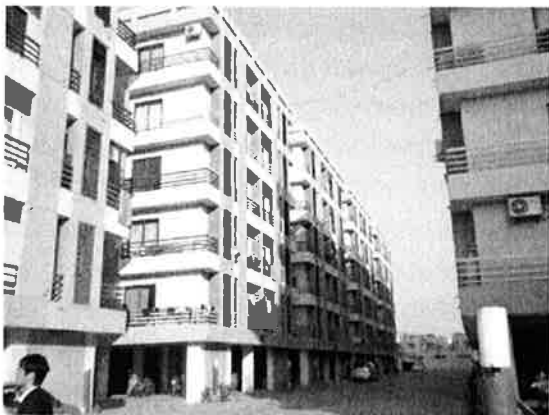
写真-7 施設3が設置されている数千人規模の新興住宅団地。
