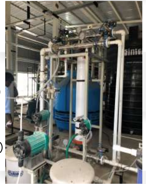
マルチフィルター（左） （砂ろ過・活性炭ろ過装置）
