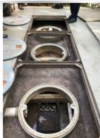
浄化槽設置状況
