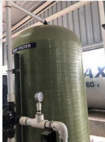
マルチフィルター（左） （砂ろ過・活性炭ろ過装置）
