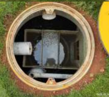
沈殿分離槽
